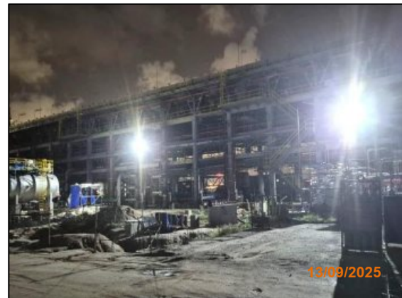
รูปที่ 2-63 การจัดเตรียมแสงสว่างให้เพียงพอระหว่างช่วงเวลากลางคืน
